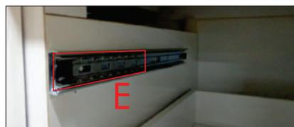
Detalhe da corrediça posicionada dentro do armário, com as esferas para frente.
