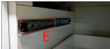
Detalhe da correção posicionada dentro do armário, com as esferas para frente.
